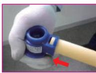
▲A部加工面にポリブテン管を差し込みます。
