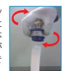
**手順11** 取り外し後は、樹脂管にストッパ痕(傷)が残りますので、管端から50mm以上の位置で切断しうえてご使用ください。樹脂管の傷は、漏水の原因になります。
