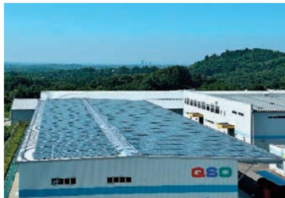
当社は、2024年11月に環境保護とエネルギーの効率化を目指し、福島工場の生産棟屋根に太陽光発電システム（発電容量375kW）を設置いたしました。
