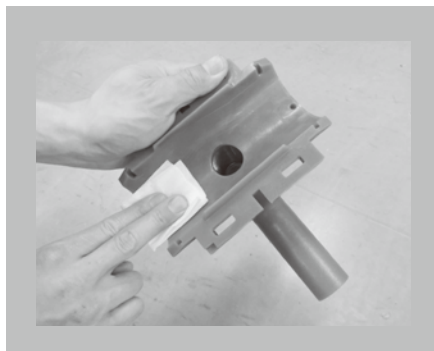
融着面の清掃(管とサドル)
