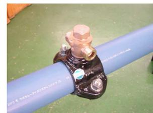
写真13. キャップの取付け
