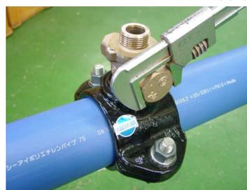
写真4. キャップの取付け
