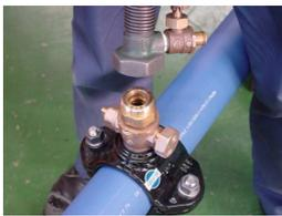
写真9. 穿孔機の取付け
