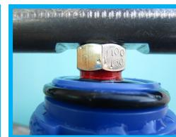
写真 20(写真はφ100,150 止水位置)
