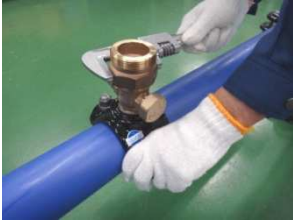
写真5. アダプタの取付け
