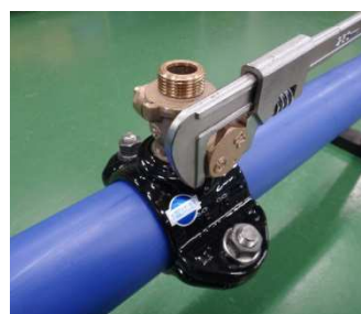
写真4. キャップの取付け
