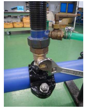
写真12. 分水栓の閉止
