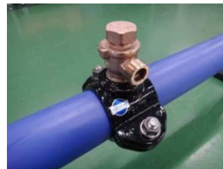
写真13. キャップの取付け
